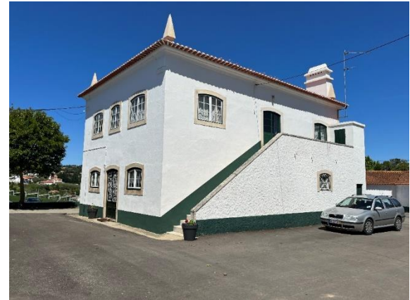
Eines von mehreren Einzelgebäuden der Schule
